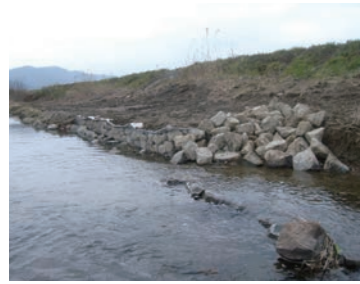
ふとん籠設置状況
