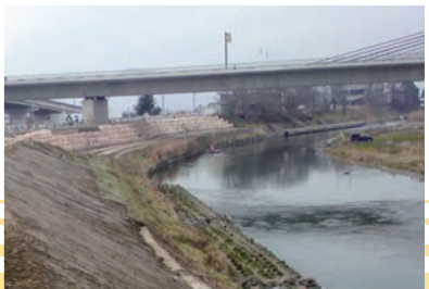
桂川工事箇所
