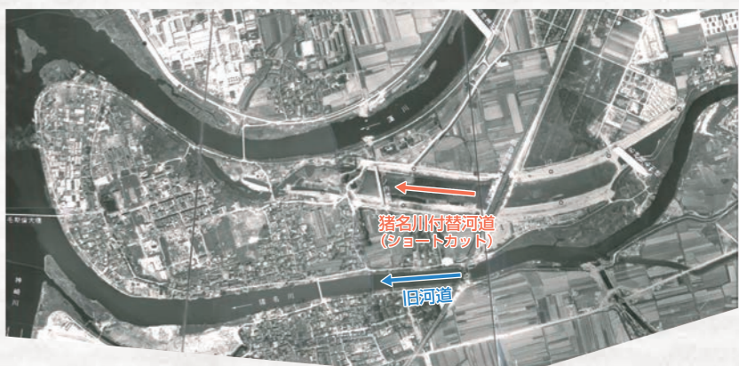
猪名川付替河道（戸ノ内捷水路）の建設 （写真提供：猪名川河川事務所 昭和36年5月撮影）
