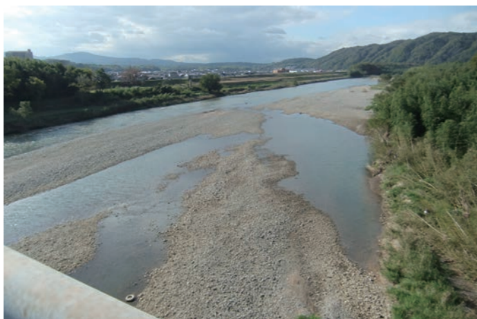
恭仁大橋より下流を望む
