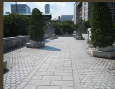
植栽で整備された歩行者専用橋
