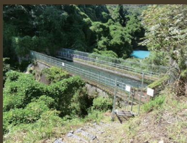
隧道間を結ぶ水路部分
