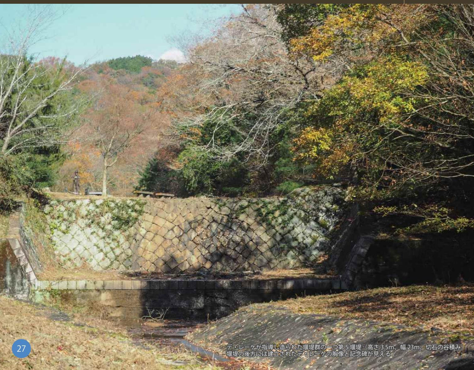
デ・レーケが指導し造られた堰堤群の一つ第5堰堤(高さ3.5m、幅23m、切石の谷積み)
