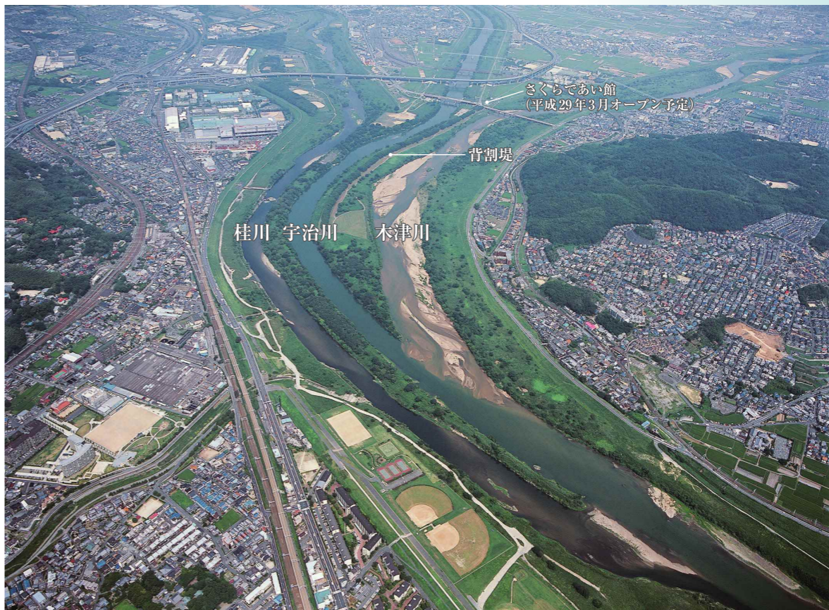
三川合流部 【写真提供：淀川河川事務所】
