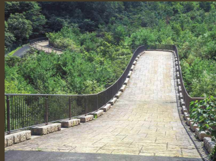
有馬街道側から見た蓬莱峡堰堤。S字型の管理用通路の下には、太多田川（手前）と座頭谷川（奥）が流れている。近くで見ると「万里の長城」を思わせる。
