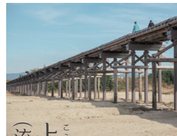
5本の杭で支える橋脚は、両端2本がこれまで使用していた松杭、中央3本がコンクリート製(L=12m)になった。このコンクリート杭は両側の松杭に合わせた塗装が施されているので、時代劇映画の撮影には支障ないのだろう。
