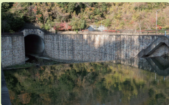
道路と河川の2つのトンネルが南北方向に並行している天野川トンネルの上流側(呑口部)。写真中央の上部に道路改良工事で新たに完成した新磐船トンネル(国道168号バイパス)がみえる。
