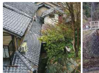
鳴子川左岸堤防から民家を見下す
