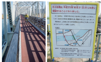
【左】木造から鉄板に変わった歩道部を自転車で渡る男性(平成23年4月)。
