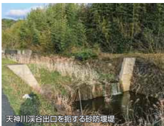
天神川溪谷出口を扼する砂防堰堤
