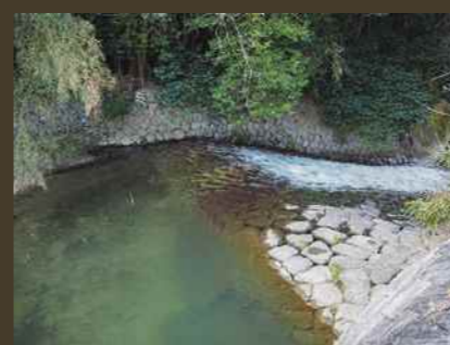
天野川砂防堰堤(上流側)
