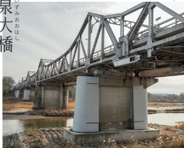
泉大橋は、奈良と京都を結ぶ主要道路の国道24号と、橋北側の交差点から三重県伊賀市へ東進する国道163号が重複する、特殊区間である。この約200m上流には、JR奈良線のトラス橋が木津川を横断している。
