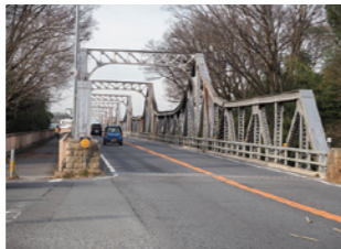
車道西側の歩行者・自転車専用橋は、昭和49年に架橋。南詰(写真手前)の木津川堤防は、嵐山(渡月橋右岸)を起点とした45kmの「京都八幡木津自転車道(桂川サイクリングロード)」の終点となっている。要所にルートマップなどがあり、嵐山まで迷わずサイクリングできる。
