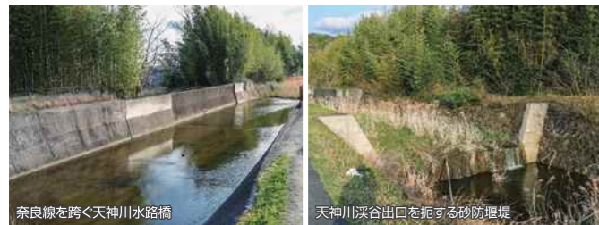
奈良線を跨ぐ天神川水路橋
