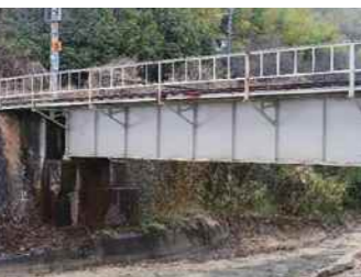
天井川(鳴子川)を渡る奈良線
