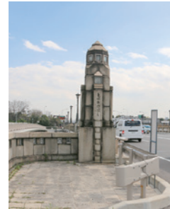
橋の両端部の4か所には、橋の名前や流っている河川名などが記された親柱が設置されています。戦前の橋には、地域のシンボルとするため意匠を凝らしたものが多く設置されていました。鳥羽大橋の親柱は、特に大きく有名です。
