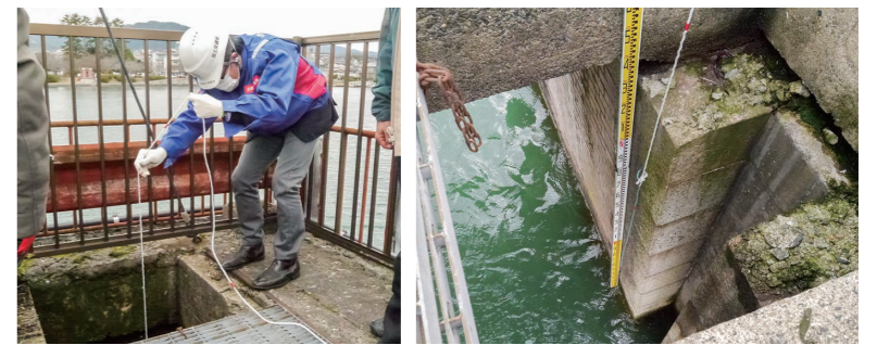
写真-4 旧洗堰の測量状況
