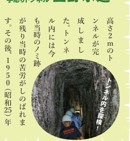
る余呉川の下流部にある江戸に造られた洪水防御のためのネルです。滋賀県の治水に開最も古い歴史的施設です。この点の長浜市高月町西野は、山また低地のため、当時浸水された被害が繰り返されていました。特に、1807（文化4）年洪水は、惨状を呈し、地元の莊上人が彦根藩や幕府を説得して、住民の協力により造成されました。1840（天保11）年に人力による掘削が開始され、岩盤の硬さ、落盤事故、資金不足を乗り越え、1845（弘化2）年に長さ220m、幅1・2m、
