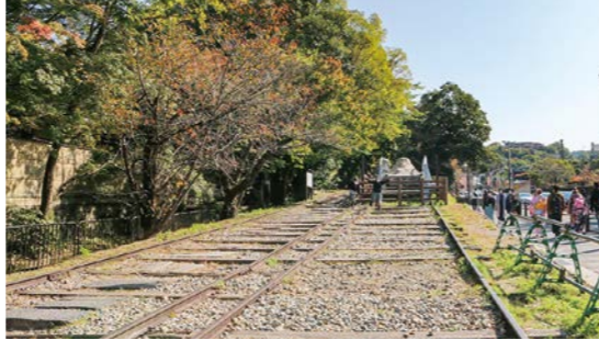
インクライン 中央にあるものはかつて荷船を運んだ台車
