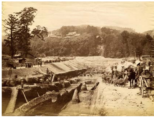
第1 疏水大津運河工事 (明治19年頃撮影「田邊家資料」)
