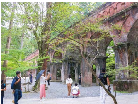
田辺朔郎の設計によるレンガ造りの水路閘
