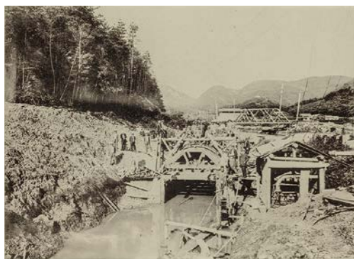
第2 疏水柳山トンネル東口埋立水路工事 (明治42年9月22日撮影)
