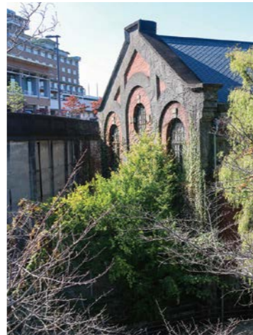
旧 蹴上発電所
