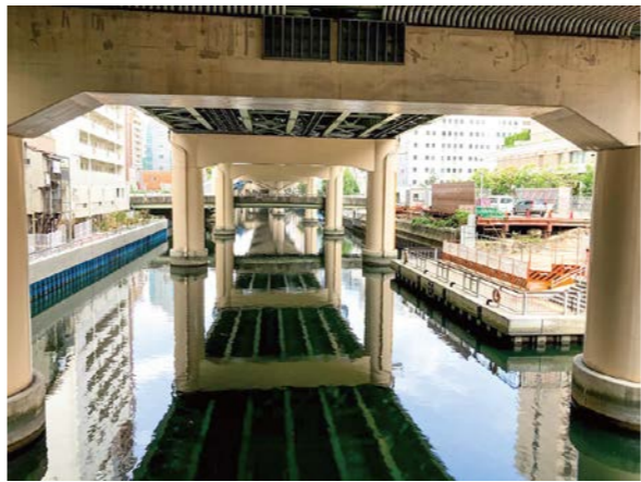
東横堀川(右側は工事中の船着き場)
