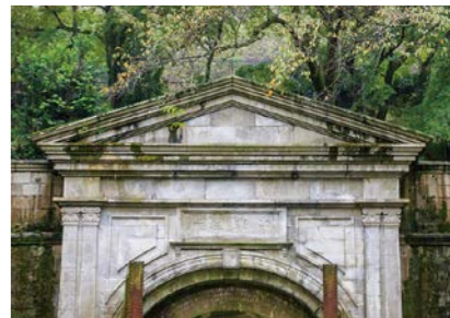
第一トンネルの入り口と篆額
