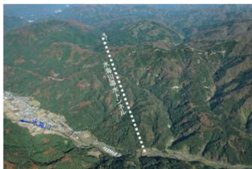
水海川導水トンネル全景
