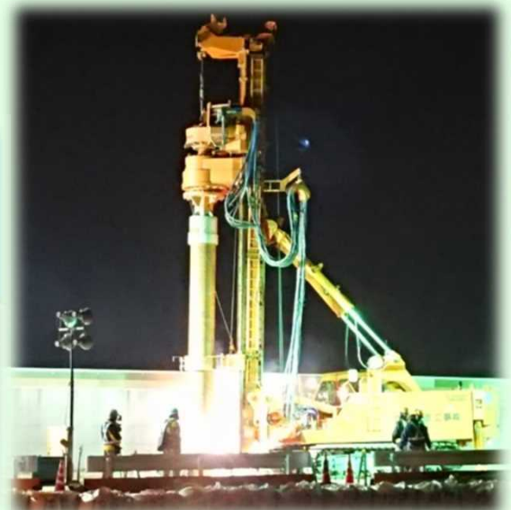
本現場での施工状況(夜間工事)
