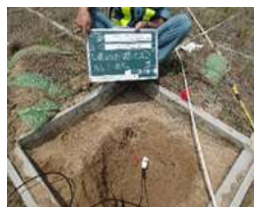
写真-1 土壤水分センサ設置状況
