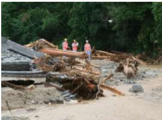
朝倉市杷木星丸地区の 土石流被災箇所での作業風景
