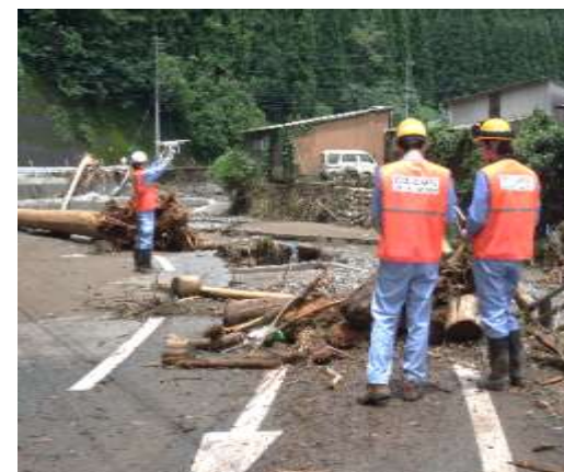
朝倉市佐田地区での作業風景
