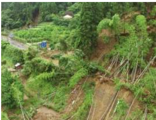
国道211号の土砂崩落箇所 東峰村小石原鼓地区
