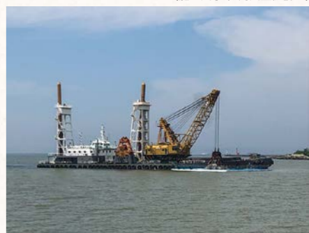
河口部浚渫工事
