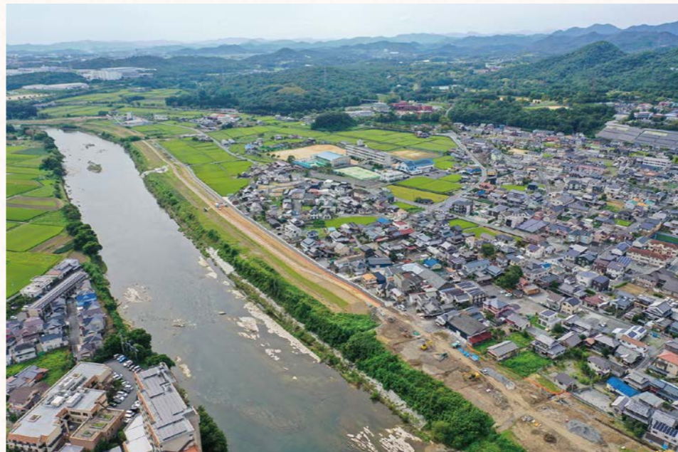
上流部河川拡幅工事（滝野地区）
