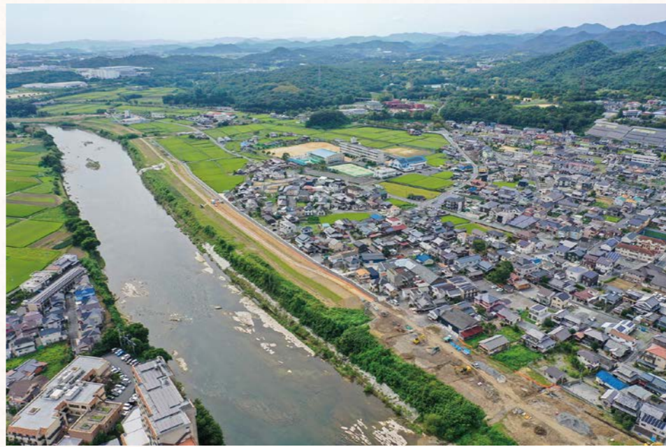
上流部河川拡幅工事（滝野地区）
