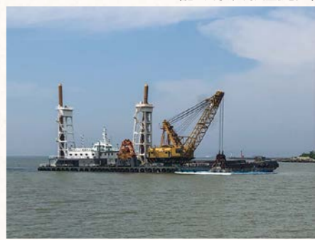
河口部浚渫工事
