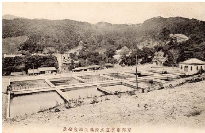
図-6 蹴上浄水場【京都市水道水源池沈殿池全景】 (絵葉書：明治45年～大正6年)
