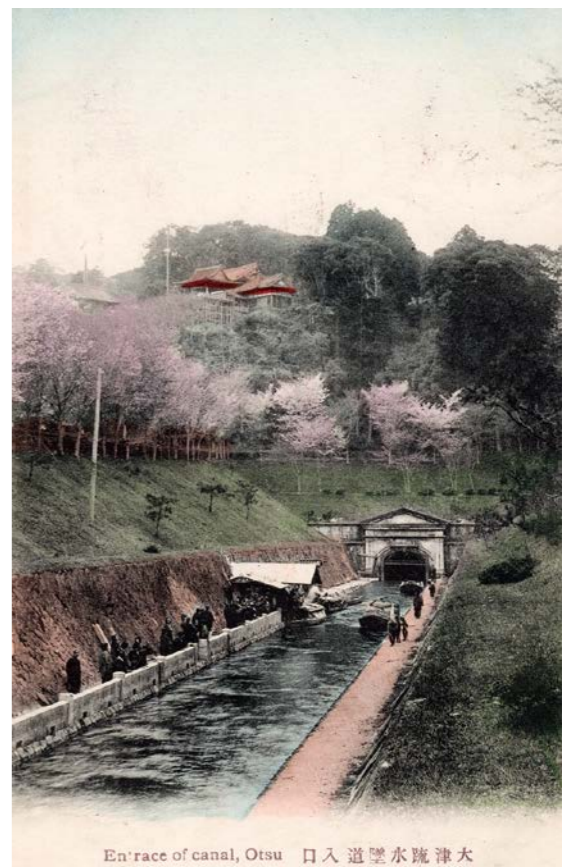
図-1 琵琶湖疏水の入口（大津） 田邊朔郎が東京の知人に送付した絵葉書（消印：明治42年4月17日）
