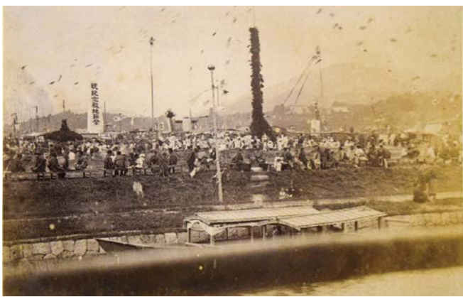
図-3 第4回内国勧業博覧会において建立された平安神宮の地鎮祭 (写真：明治23年9月3日)
