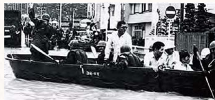
昭和51年 洪水による高砂市内の浸水（加古川水系 河川整備計画）
