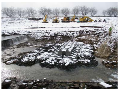
写真-4 ブロック設置状況
