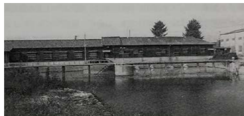
廃止された排水機場(昭和4年、昭和24年設置) 出典: 綴喜西部土地改良区50周年記念誌
