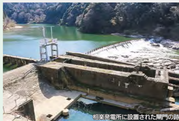
相楽発電所に設置された閘門の跡
