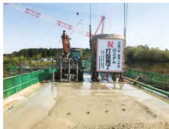
コンクリート打設完了時の状況
