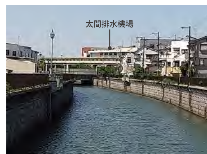
写真1-3 寝屋川導水路(前方は太間排水機場)
