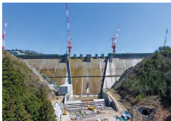
コンクリート打設を終えた川上ダム
