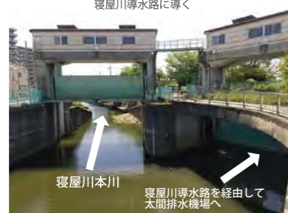
写真1-2 寝屋川本川に設置された桜木水門
