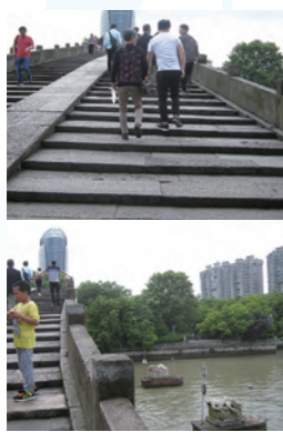
雄大な傾斜が特徴的な拱宸橋
