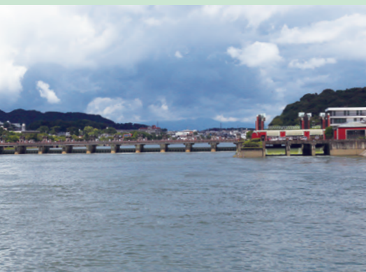
瀬田川洗堰とバイパス水路
