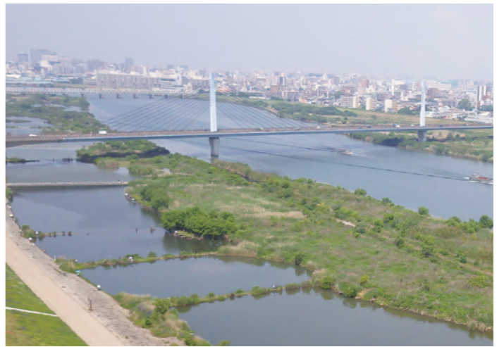
大阪工業大学構内より下流側を望む【写真1】
