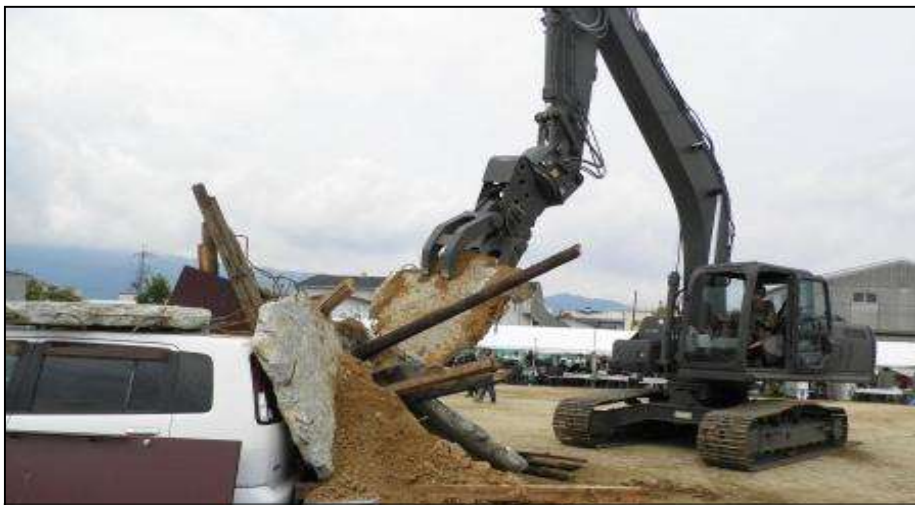
油圧ショベル：瓦礫等の除去に使用
