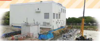
呑龍ポンプ場と 工事中の調整池
