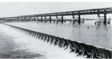
長柄起伏堰(昭和10年「可動堰」に更新)【提供：淀川資料館】
