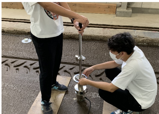
図-7 小型 FWD 試験による地盤反力係数の計測
