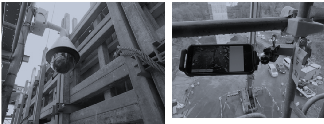
出所) 善本撮影, 2021年11月(撮影協力: 阿部建設)。
