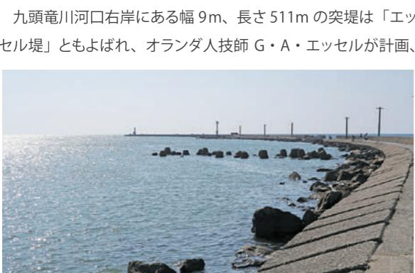
ヨハネス・デ・レーヶ監督し、オランダ土木技術であった粗朶沈床工が我が国で初めて河口処理に用いられた構造物です。明治6年にオランダから招かれたエッセルは、氾濫を繰り返す九頭竜川や足羽川などで、護岸や水制として沈床工の指導を行いました。また、九頭竜川河口の三国港では、土砂堆積により河床が高くなり、船舶の航行に支障をきたしていました。そこで、エッセルは九頭竜川河口右岸に導流堤を築き、その対岸には水制を設置して河口の流速を速め、土砂の沈降を防ぐ方法を採用しました。エッセル堤は重要文化財に指定され、現在も導流堤兼防波堤としての機能を果たしています。
