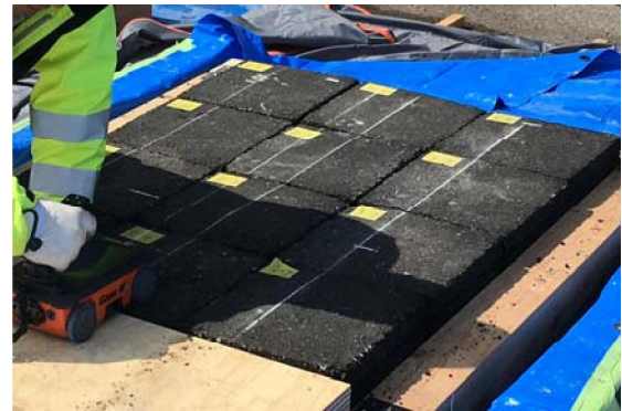
写真-12 ハンディ型電磁波レーダの計測状況
