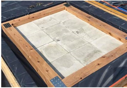
写真-7 コンクリート平板の設置状況
