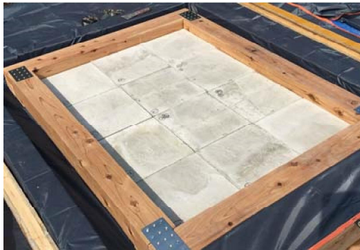
写真-7 コンクリート平板の設置状況
