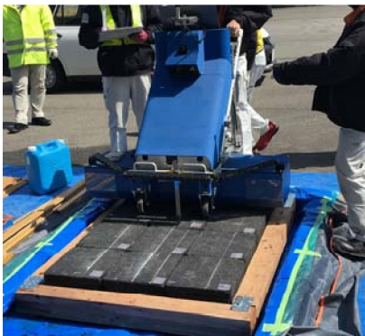
写真-11 手押し型電磁波レーダの計測状況
