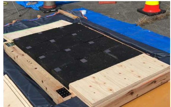
写真-8 舗装体の設置状況
