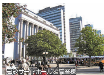
コンサートホールと高層棟
