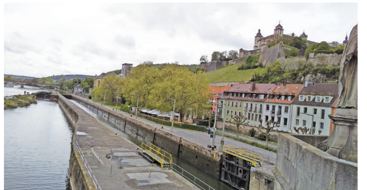
アルテ・マイン橋から見たヴェルツブルク閘門とマリエンベルク要塞
