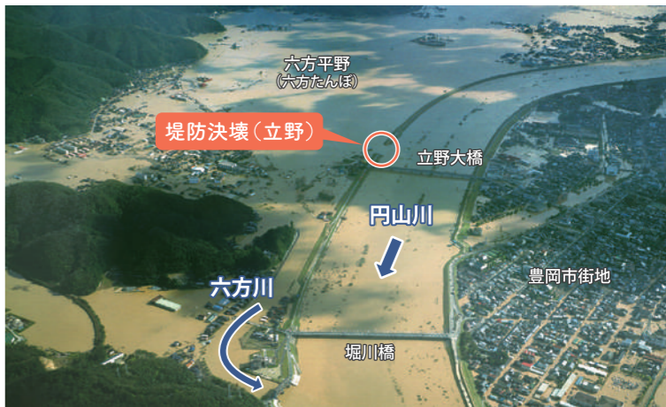
円山川決壊(立野地点(右岸13.2km付近)の状況)【出典】豊岡河川国道事務所
