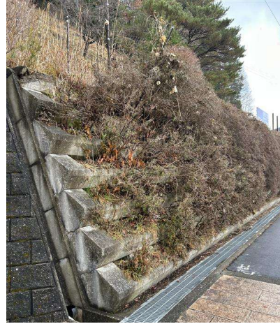
写真-8 土砂災害対策工の様子（高野山）
