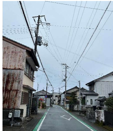
写真-14 電線の様子 (新宮市)
