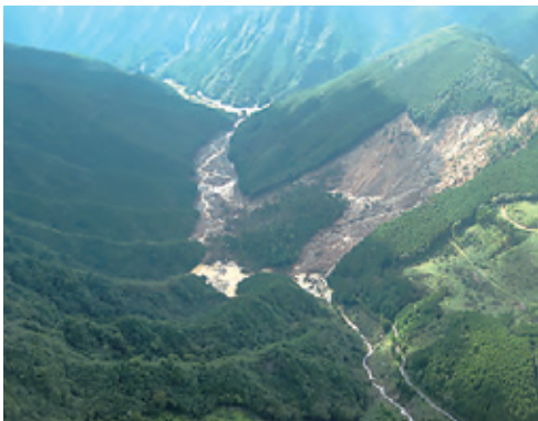
熊野地区の深層崩壊と河道閉塞
