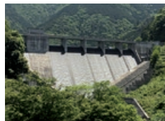
野洲川ダム(滋賀県甲賀市) 【出典：近畿農政局】
