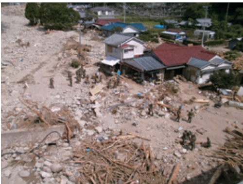
那智勝浦町那智川の土砂災害
