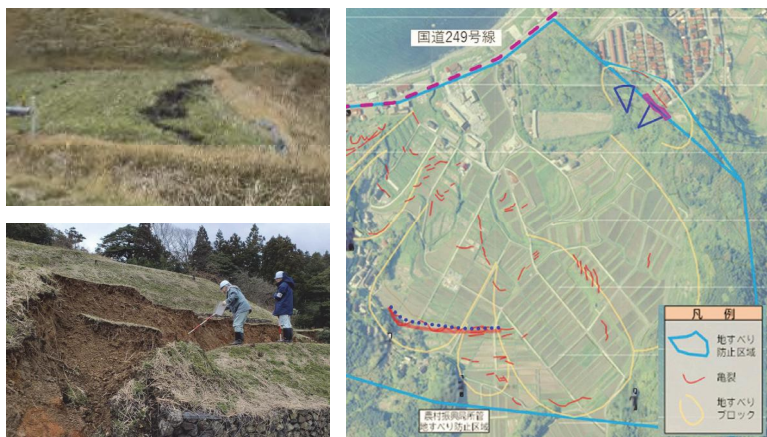
図-2 稲舟地区の被災状況 3)
